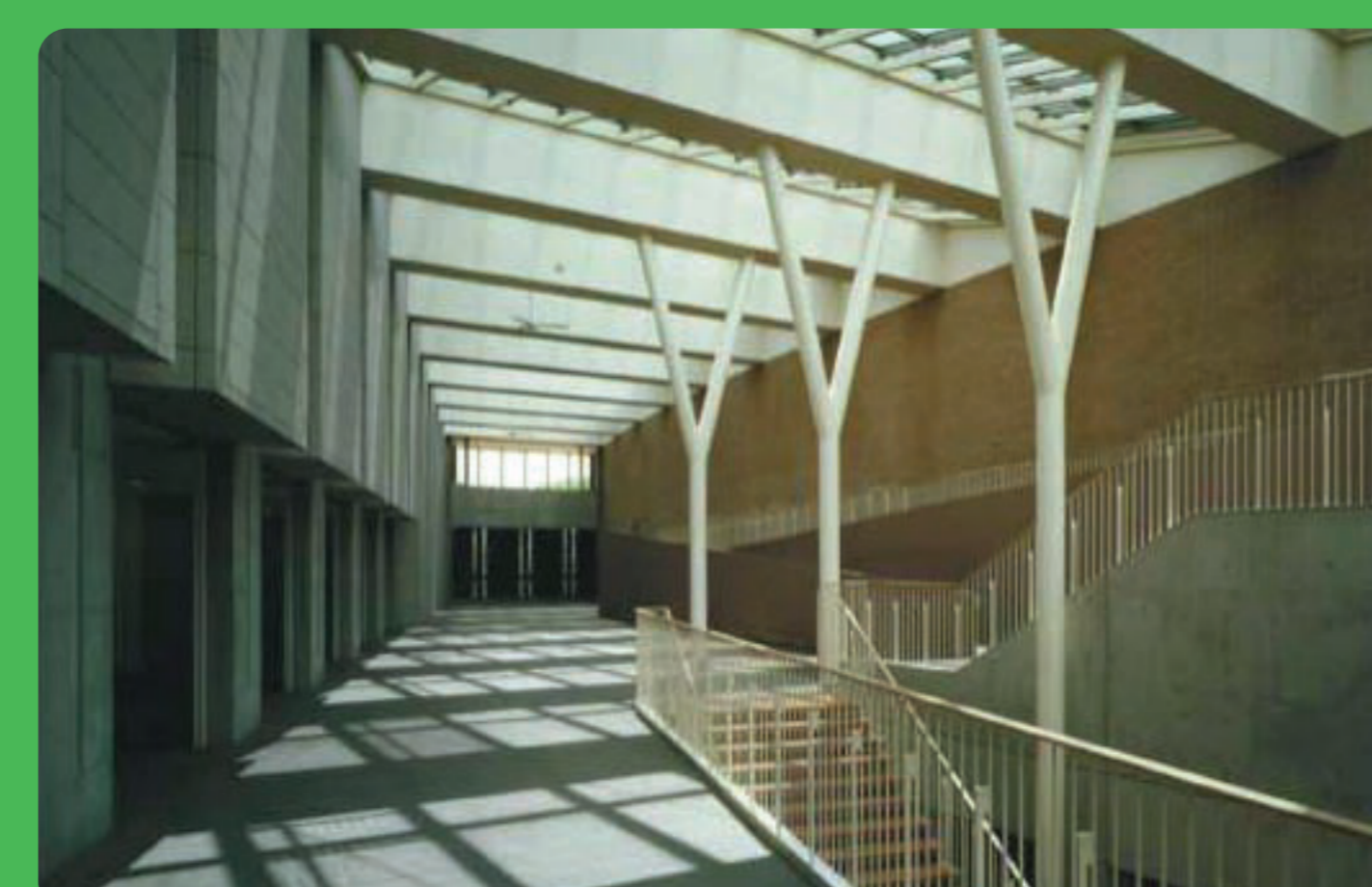
床タイル：洗足学園大学 ガラスびん70%含有の再資源化タイル。バージン製品製造時に比べ低温焼成が可能となり、26%のCO 2 排出を抑制できる。
