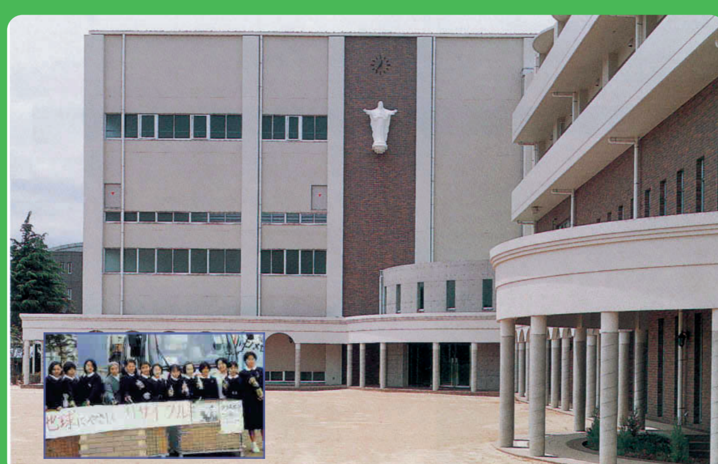
壁タイル・床タイル：愛徳学園中学校高等学校 生徒が回収したガラス瓶リサイクル運動から、校舎タイルが出来ました。
