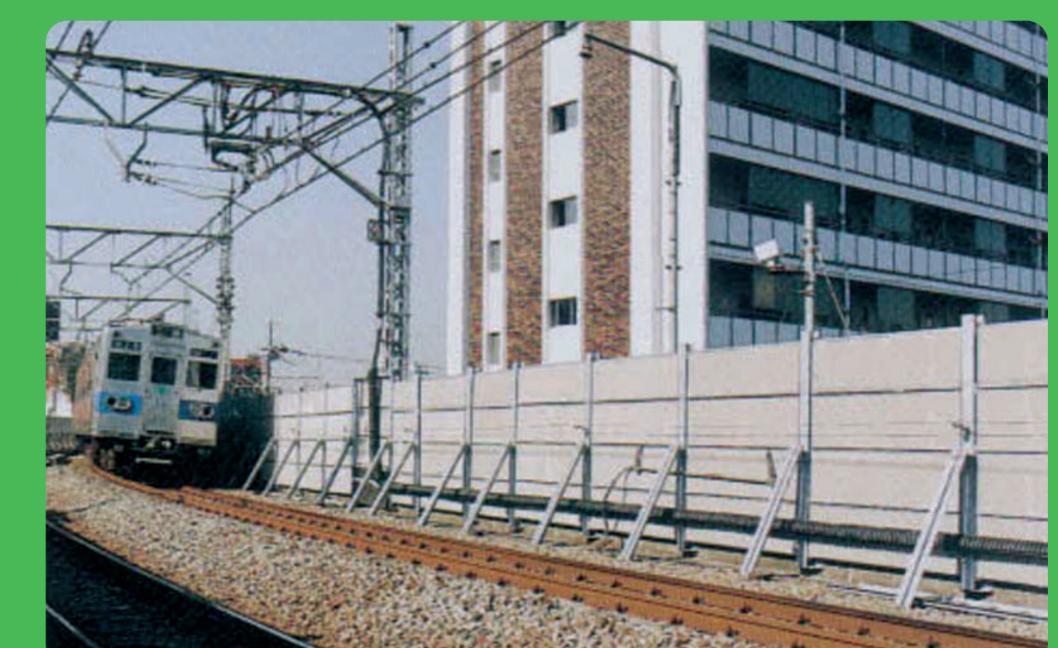
防音パネル：都営地下鉄三田線 吸音特性に優れています。ガラス発泡骨材Gライトを主原料としたリサイクル商品。エコマーク認定。
